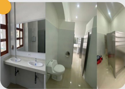
Adecuación de Baterías Sanitarias del Centro de Investigaciones y Estudios Socio Jurídicos (CIESJU) y la adecuación de baterías sanitarias en el centro Cultural Palatino con una Inversión de: $ 101.656.262 y $ 20.781.933
