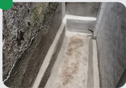
Adecuación de Canales e Impermeabilización para la Sede Túquerres con una Inversión de: $38.300.000
