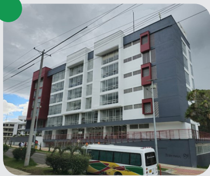
Obras de Zonas Libres y Comunes para el Bloque 1 Sur en la Sede Torobajo con una inversión de: $ 1.655.234.918
