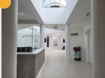
Las adecuaciones Prioritarias para la Habilitación de la Clínica Veterinaria en la Sede Torobajo con una Inversión de: $ 517.054.504
