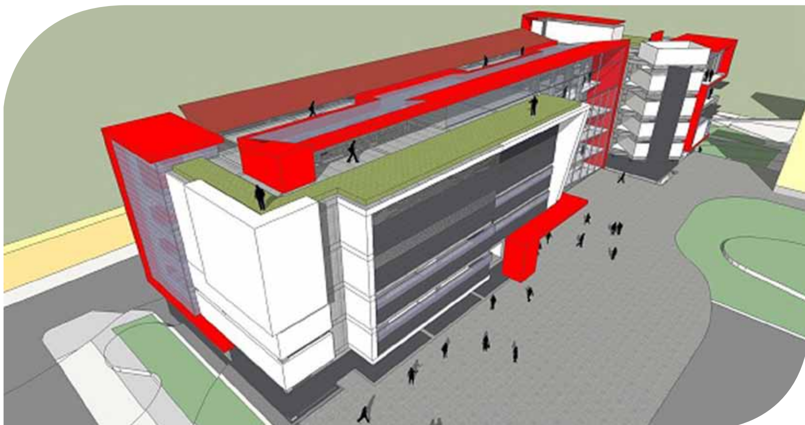
Vista semi-aérea del costado occidental del Nuevo Edificio de Aulas y Tecnología, actualmente en construcción. El diseño obedece a criterios de eficiencia bioclimática y de bajo impacto ambiental.
